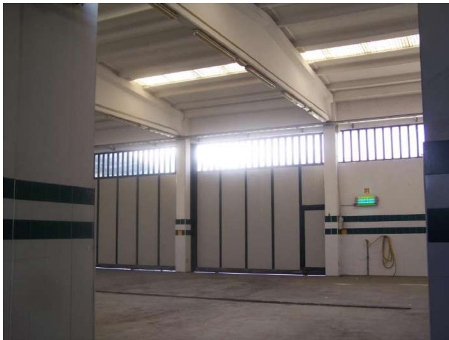
Foto n. 26: Interno capannone immobile Orta Nova NCEU Foglio 29 P.IIa 508 sub.1
