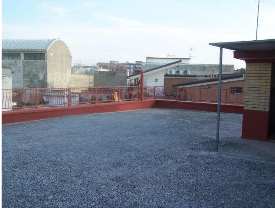
Foto n. 51: Terrazzo copertura immobile Orta Nova NCEU F.22 P.Ila 685 sub.1-2
