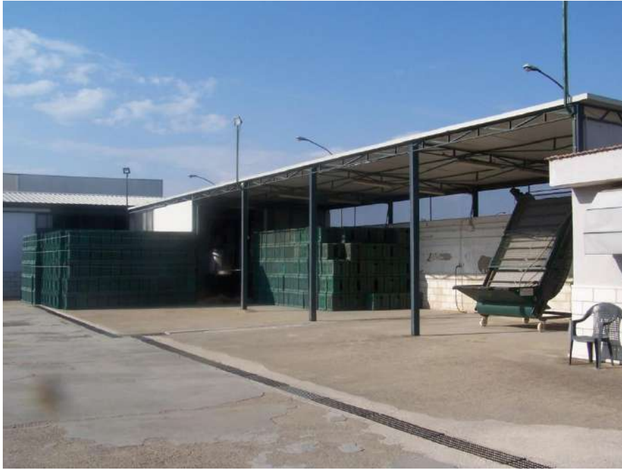
Foto n. 5: Tettoia laterale destra immobile Orta Nova NCEU Foglio 29 P.IIa 507
