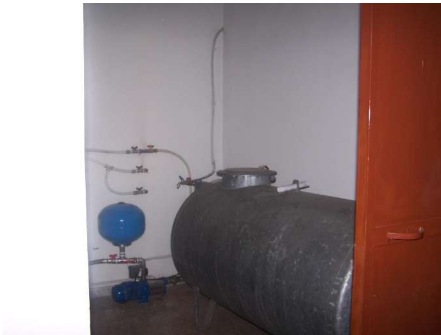
Foto n. 36: Locale deposito Immobile Orta Nova NCEU F.22 P.Ila 685 sub.1
