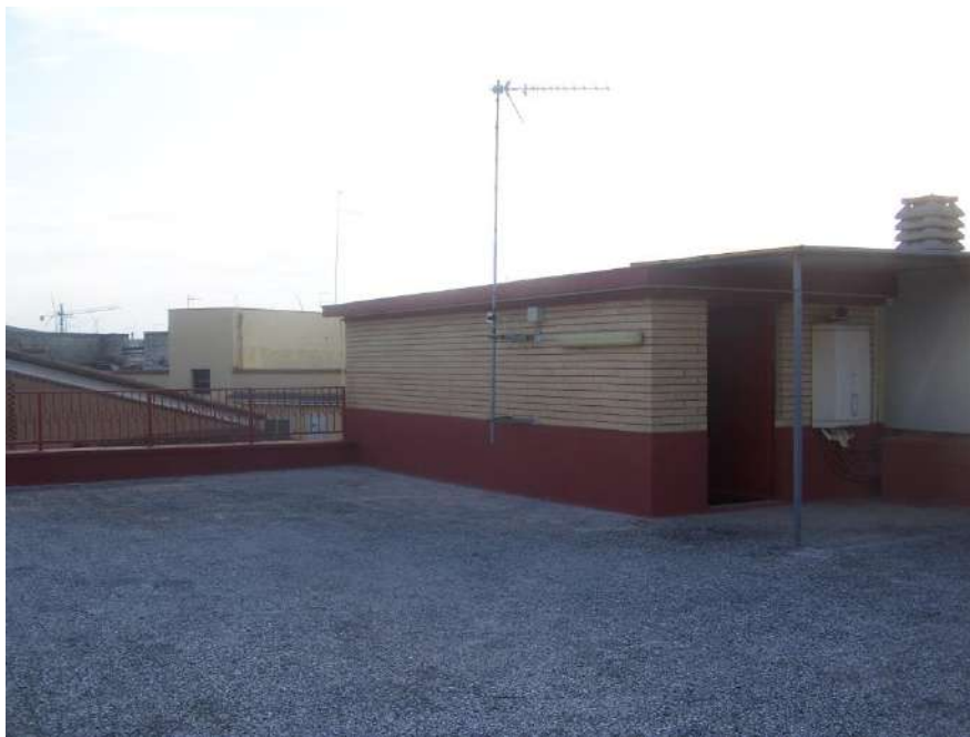
Foto n. 52: Terrazzo copertura immobile Orta Nova NCEU F.22 P.Ila 685 sub.1-2
