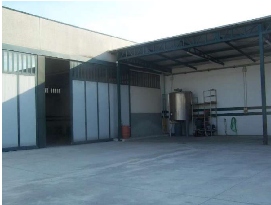
Foto n. 24: Ingresso capannone e tettoia immobile Orta Nova NCEU Foglio 29 P.Ila 508 sub.1
