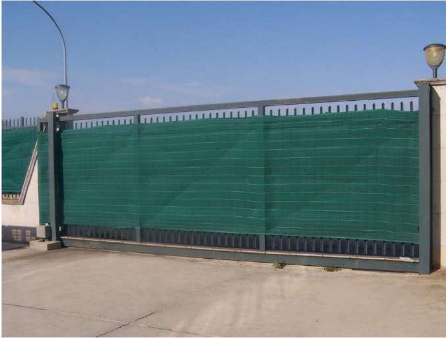
Foto n. 19: Ingresso immobile Orta Nova NCEU Foglio 29 P.IIa 508 sub.1
