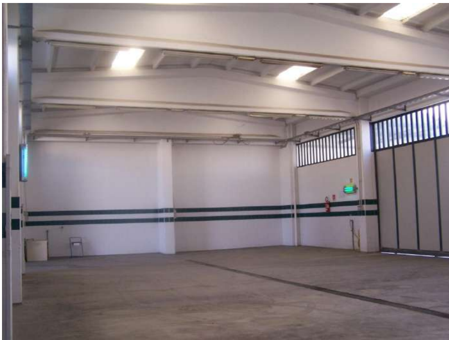
Foto n.30: Interno capannone immobile Orta Nova NCEU Foglio 29 P.Ila 508 sub.1
