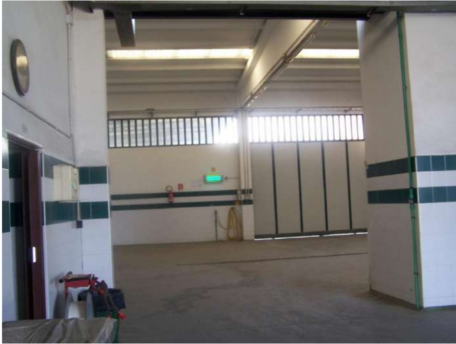
Foto n. 27: Interno capannone immobile Orta Nova NCEU Foglio 29 P.IIa 508 sub.1
