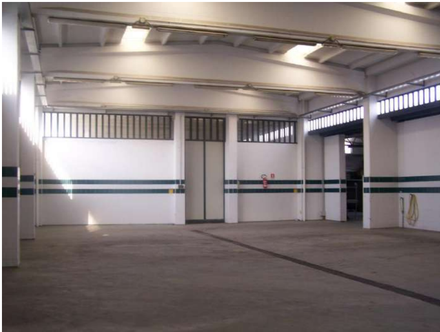
Foto n.32: Interno capannone immobile Orta Nova NCEU Foglio 29 P.Ila 508 sub.1
