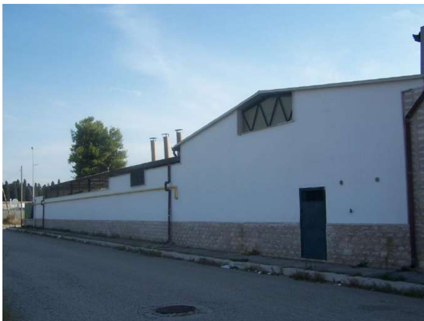
Foto n. 15: Esterno recinzione ed accesso pedonale immobile Orta Nova NCEU Foglio 29 P.Ila 507
