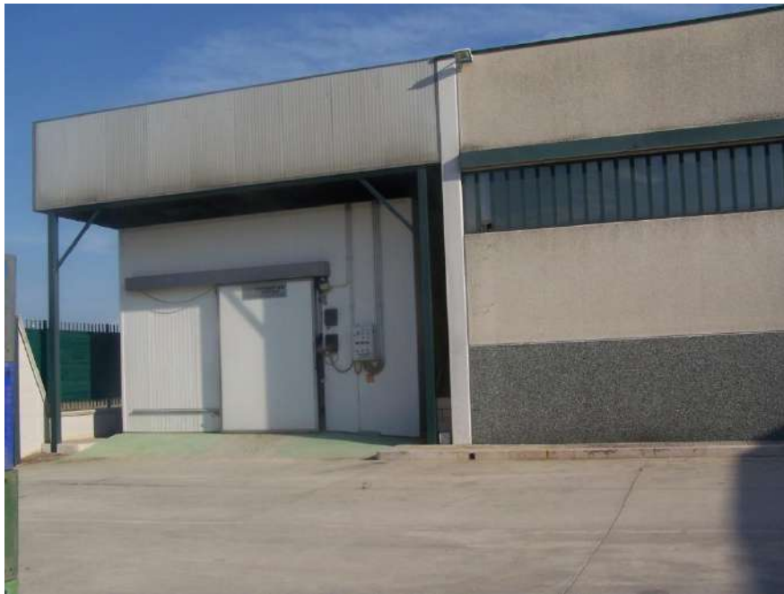
Foto n. 22: Cella frigo immobile Orta Nova NCEU Foglio 29 P.Ila 508 sub.1
