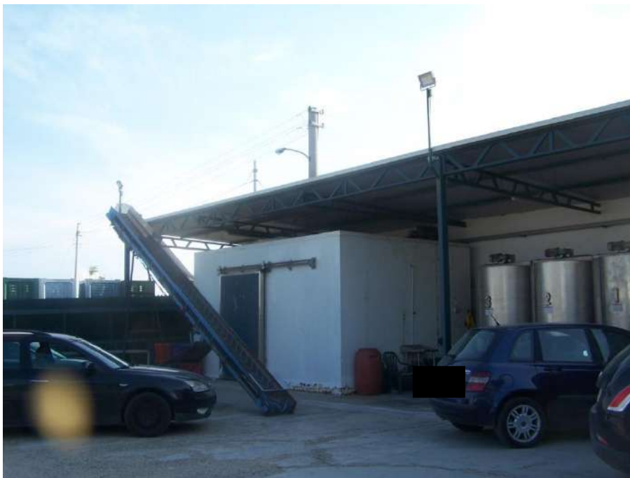
Foto n. 8: Tettoia laterale sinistra e cella frigo immobile Orta Nova NCEU Foglio 29 P.IIa 507
