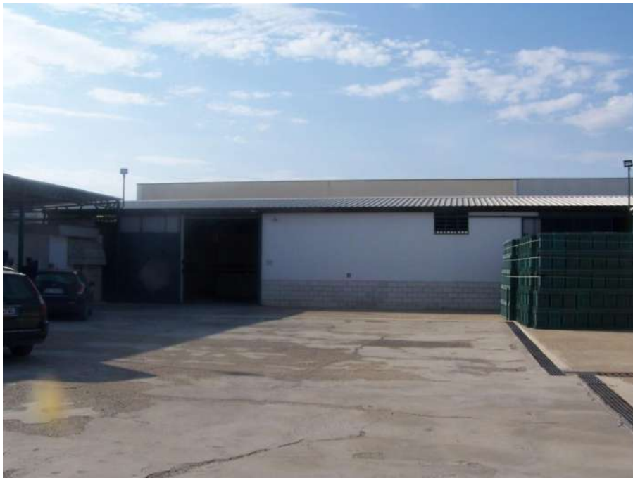
Foto n. 6: Capannone immobile Orta Nova NCEU Foglio 29 P.IIa 507
