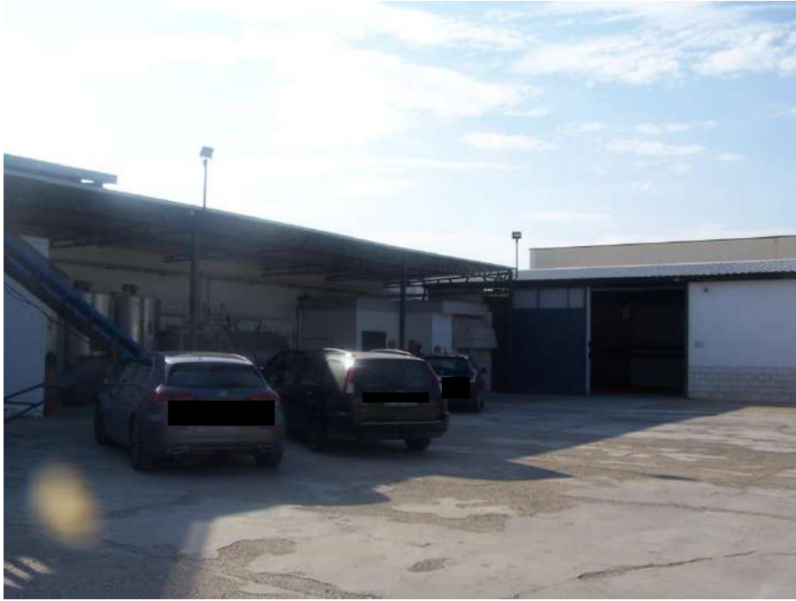
Foto n. 7: Piazzale e tettoia laterale sinistra immobile Orta Nova NCEU Foglio 29 P.IIa 507
