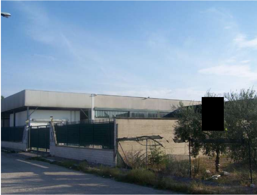
Foto n. 17: Esterno recinzione immobile Orta Nova NCEU Foglio 29 P.IIa 508 sub.1
