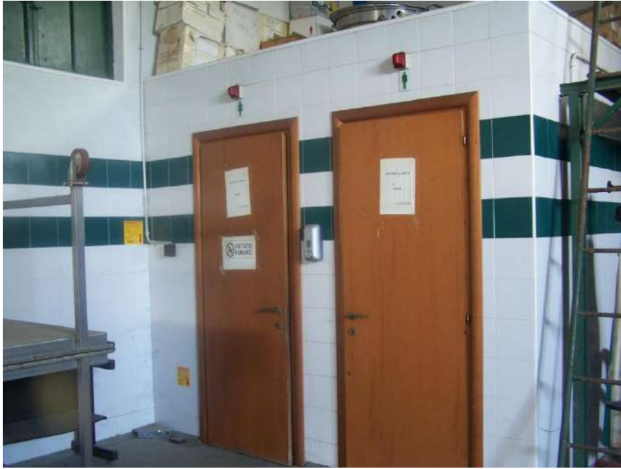
Foto n. 11: Bagni capannone immobile Orta Nova NCEU Foglio 29 P.IIa 507
