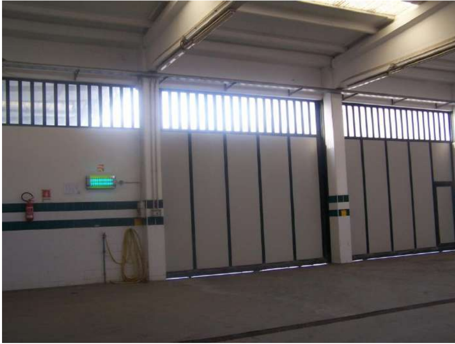
Foto n.29: Interno capannone immobile Orta Nova NCEU Foglio 29 P.Ila 508 sub.1
