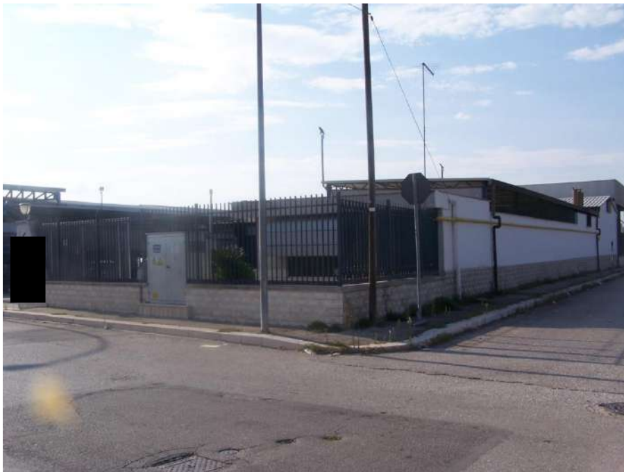
Foto n. 2: Recinzione immobile Orta Nova NCEU Foglio 29 P.IIa 507
