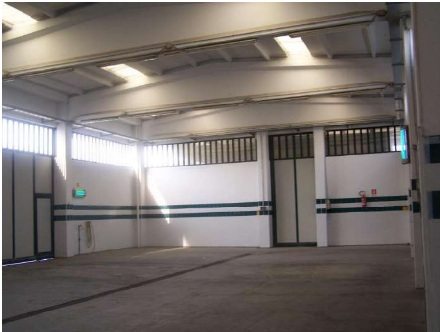
Foto n.28: Interno capannone immobile Orta Nova NCEU Foglio 29 P.IIa 508 sub.1
