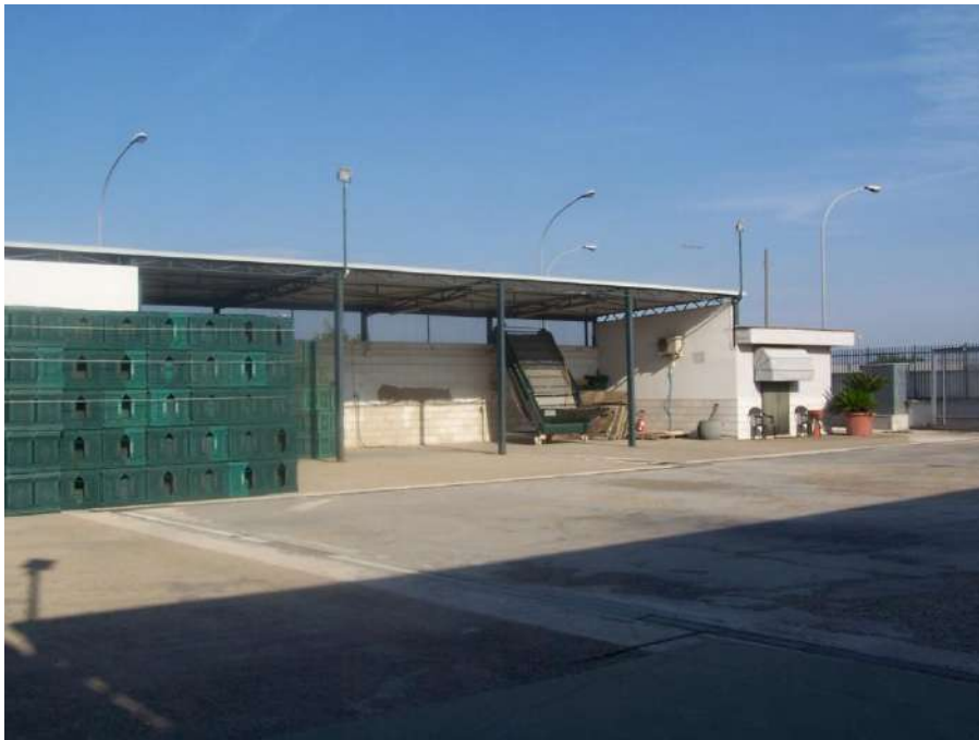
Foto n. 4: Piazzale e tettoia laterale destra immobile Orta Nova NCEU Foglio 29 P.Ila 507
