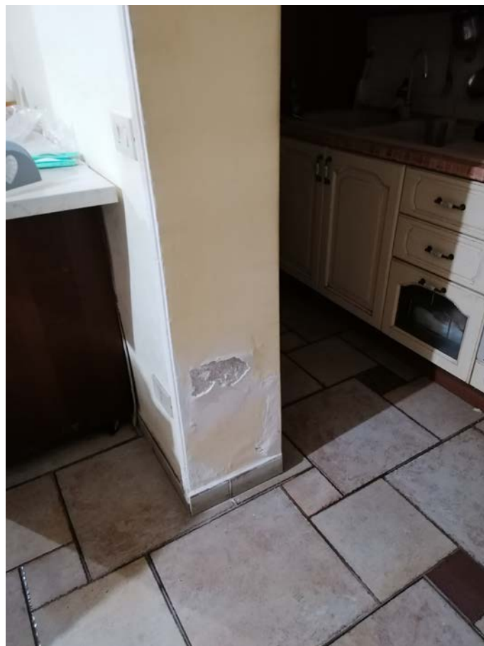
Risalita di umidità al piano terra
