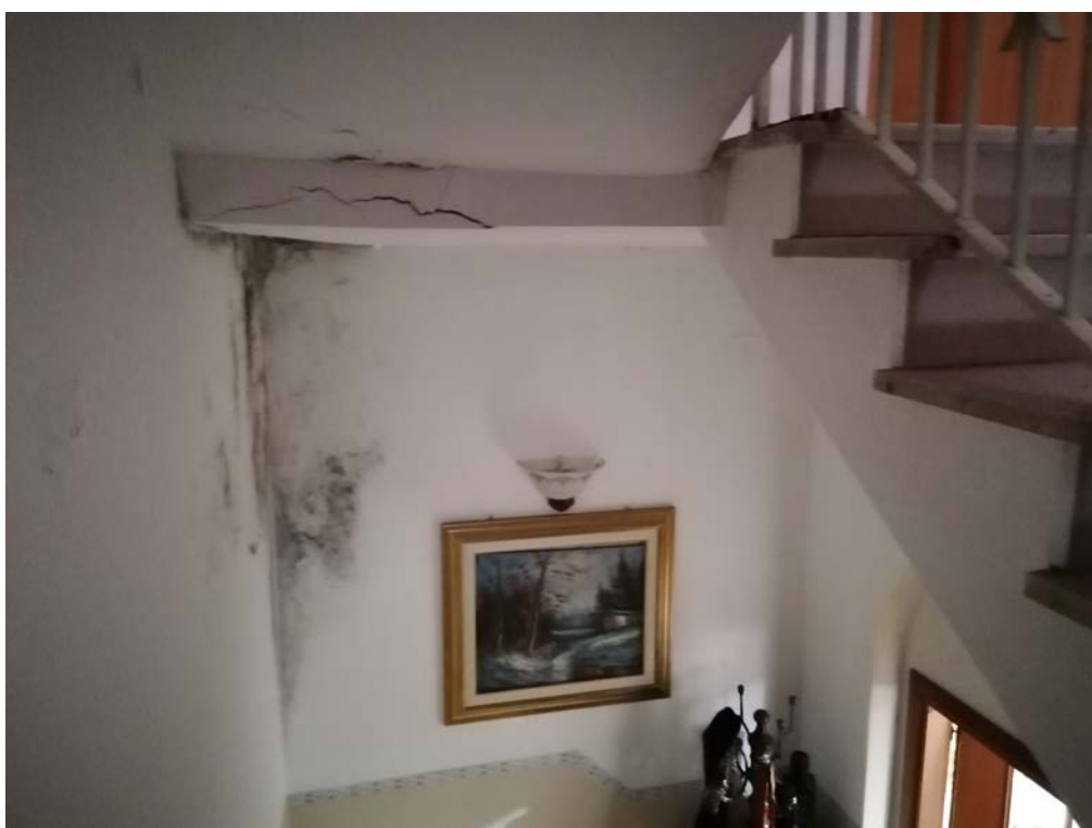
Macchie di umidità e lesioni nella scalinata
