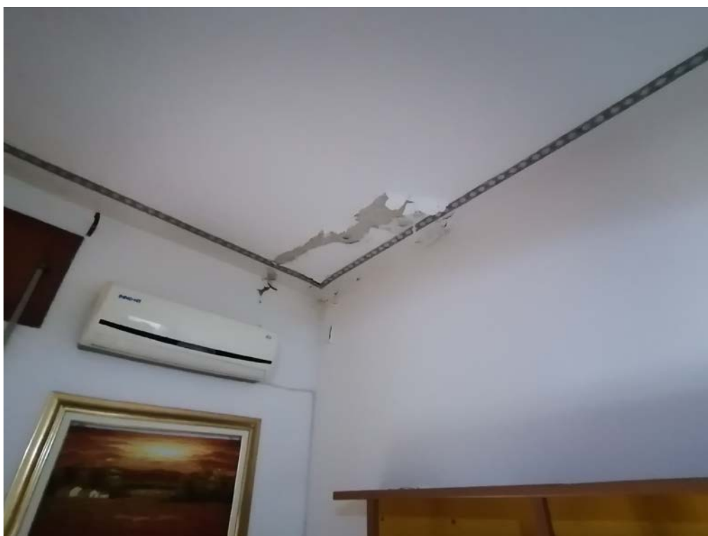
Infiltrazioni sulla volta al primo piano
