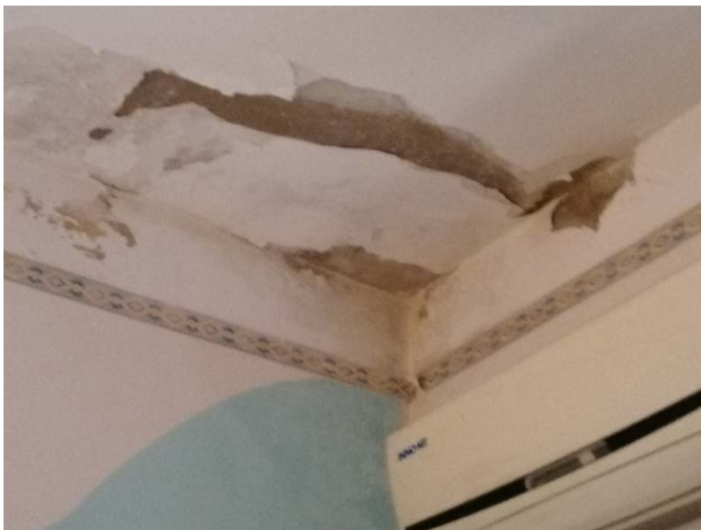
Infiltrazioni sulla volta al primo piano
