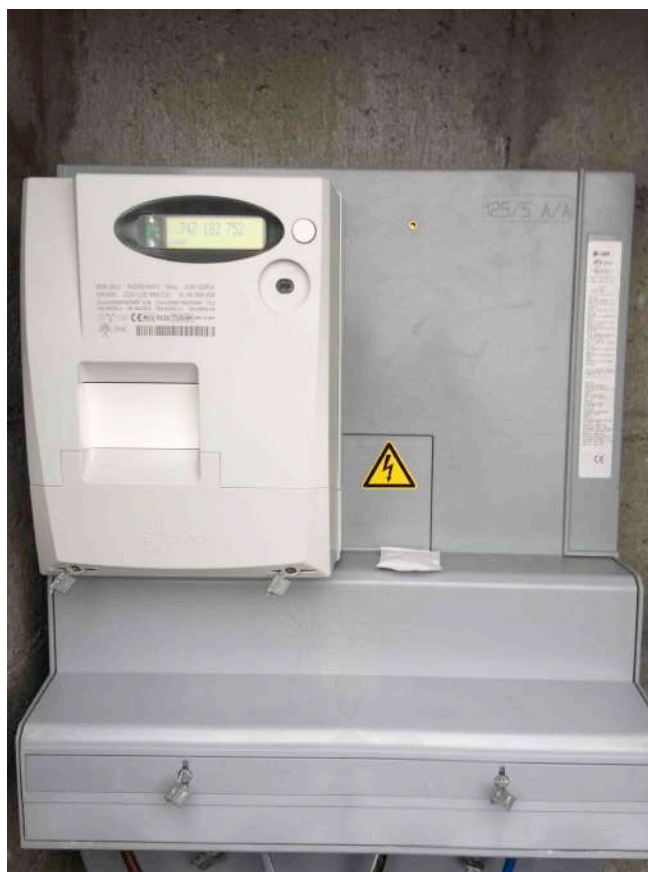
Foto 13 (contatore di immissione Enel con TA sigillati da Enel)
