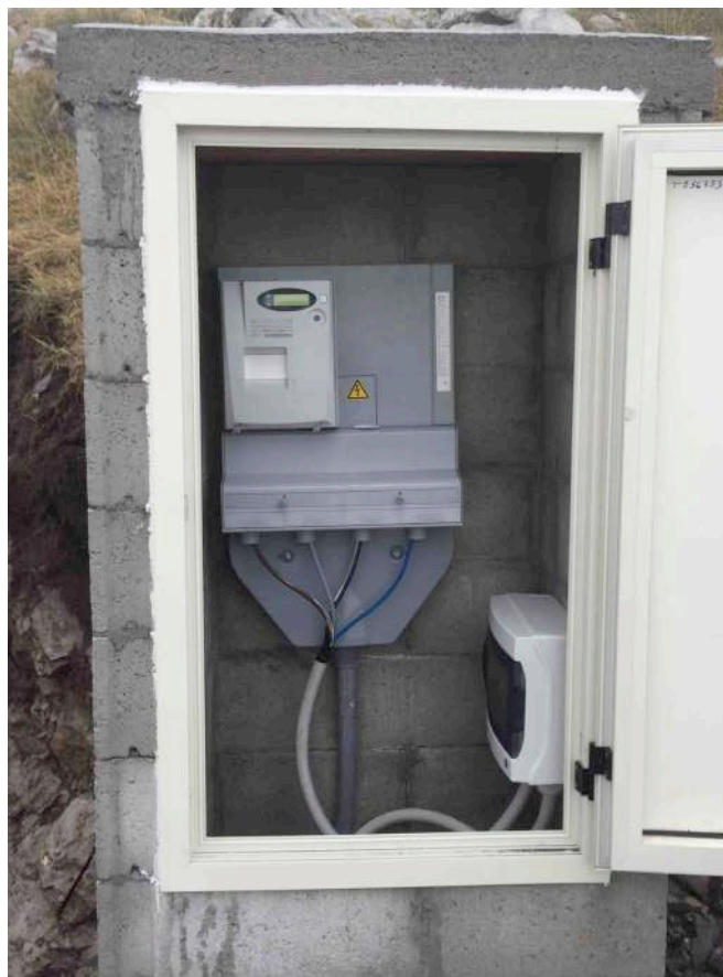
Foto n. 12 (armadio contatore di energia immessa)
